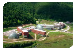
멸종위기종복원센터 위치 경북 영양군 영양읍 고월길 23 총면적 2,554,337㎡ 건축연면적 16,029㎡
