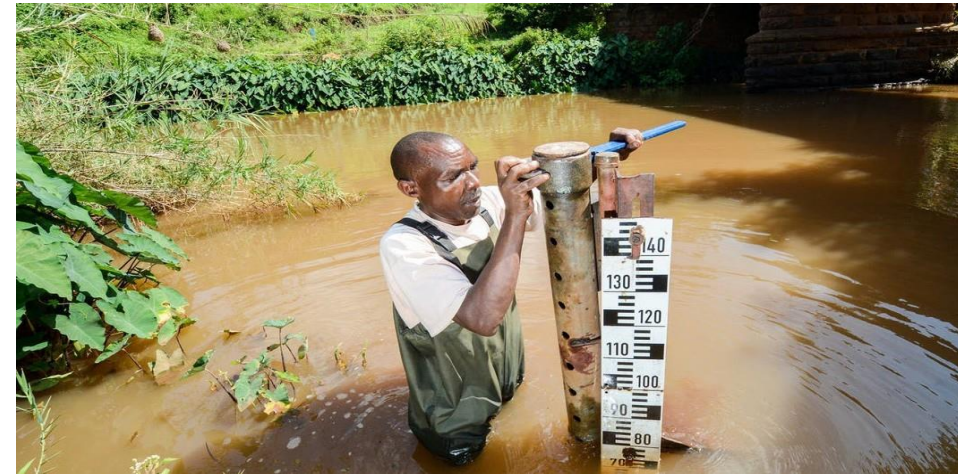
그림 7 타나 강에서 하천 수위표 지지대를 설치하고 있는 케냐 수자원관리국(Water Resource Management Authority, WRMA)의 직원 © CIAT/Georgina Smith
