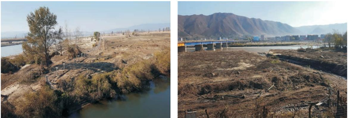
그림 11. 높아진 하상에 의해 통수단면적이 줄어들어 발생한 홍수의 영향으로 훼손된 하천변 농경지의 모습(온성)
