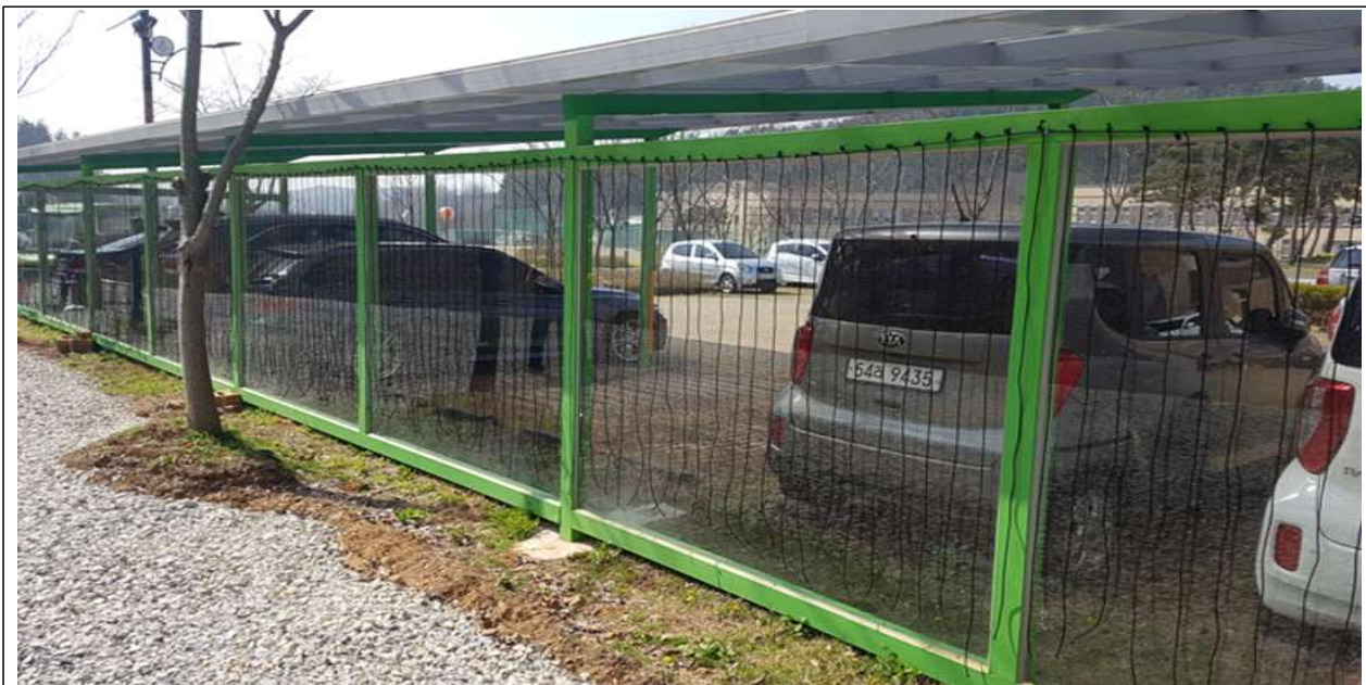
<32> 아코피안(Acopian) 충돌 방지줄 활용 사례(국립생태원)
