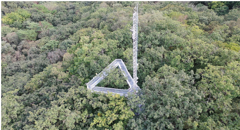
점봉산 신갈나무림 군락 위의 난류 플럭스 관측 장비 및 식생 군락의 수관부 접근이 용이한 생태타워 현장 사진
