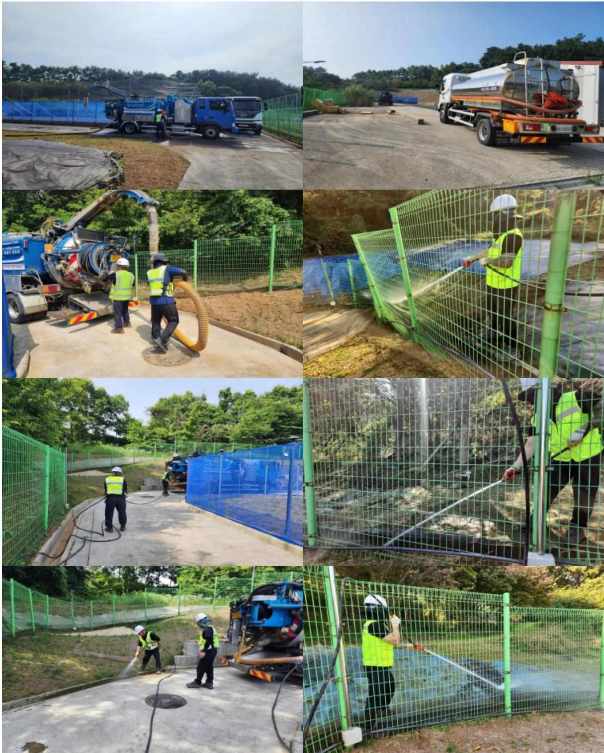
내부 배수로 준설토 제거
