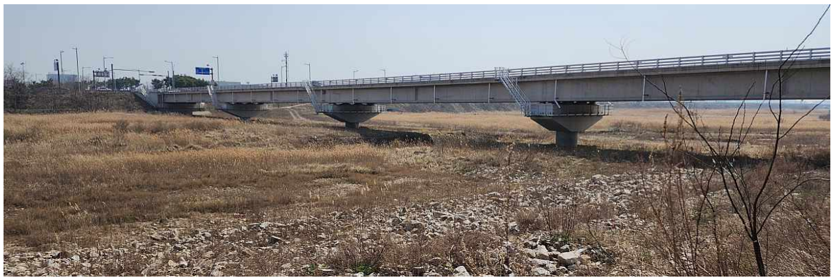
영종해안북로 운서2습지의 전경
