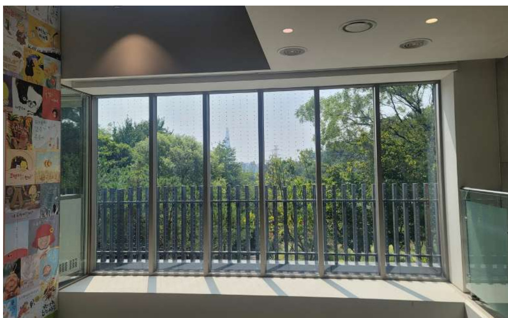
초목 근처에 자리잡은 유리창에는 새들이 충돌할 가능성이 높습니다. 이를 막기 위해 저감 테이프를 시공하였습니다. 상단은 저감처리 전, 하단은 저감처리 후 사진입니다. 저감처리를 하더라도 이용자는 시각적 개방감을 느낄 수 있습니다. (아차산숲속도서관)
