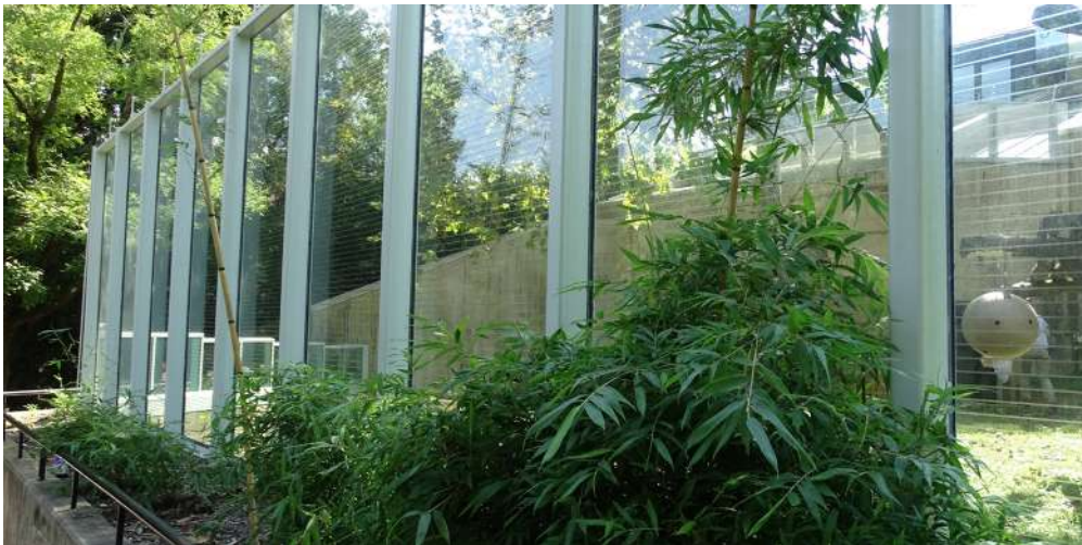
미국 스미소니언 동물원 유리난간에 선 표식이 들어간 필름을 시공하였습니다.
