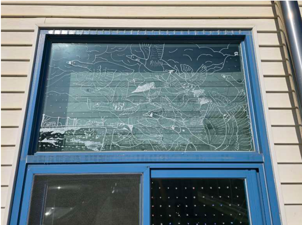
충남야생동물구조센터 유리창에 그린 그림. 내부 시야를 크게 제한하지 않고 조류 충돌을 막으면서도 센터의 특징을 보여주고 있습니다. ©충남야생동물구조센터
