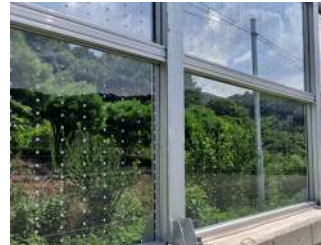
6 방음벽 「방음시설의 성능 및 설치기준」에 따라 현재 설치하는 방음벽은 조류충돌 방지기능이 있는 방음판을 사용해야 합니다.
