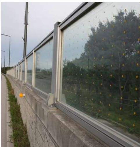
2019년 방음벽에 설치한 필름이 자외선에 의해 노후화된 모습입니다. 조류 충돌 방지 조치 내구성이 중요한 이유입니다.
