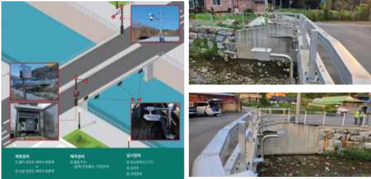
그림 12. 유량 계측관리 시스템 구성 및 설치사진(출처: 하이드로넷)
